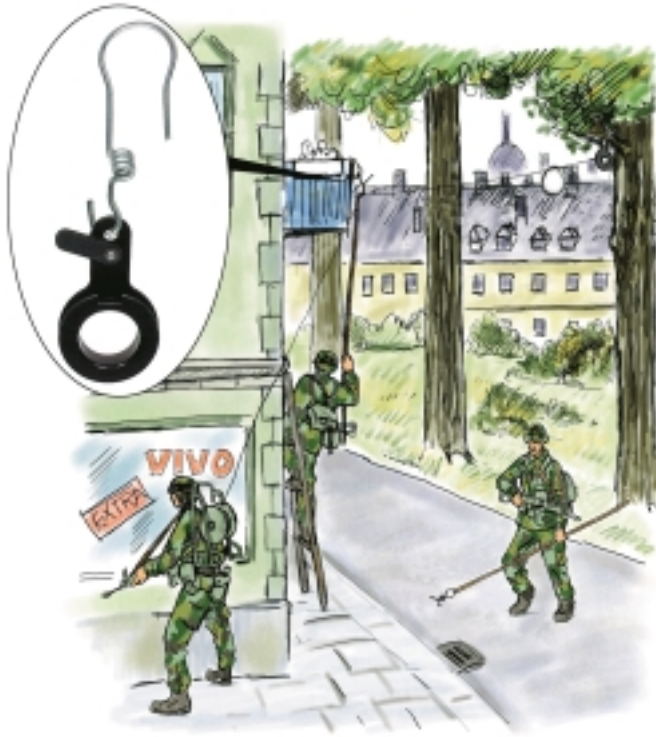
Bild 6:7 Vägport på befintliga stöd
